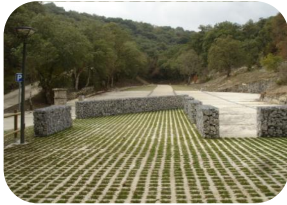
Aparcamiento jardín botánico Monasterio Santa Catalina Sierra de Bedaya- TRES PUENTES -
