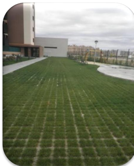
Camino de bomberos VALLADOLID
